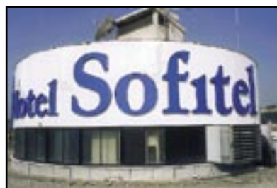
Базовая станция, встроенная в фасад здания
